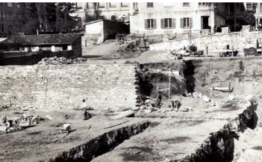
■ I lavori preliminari di sterro sono a buon punto
